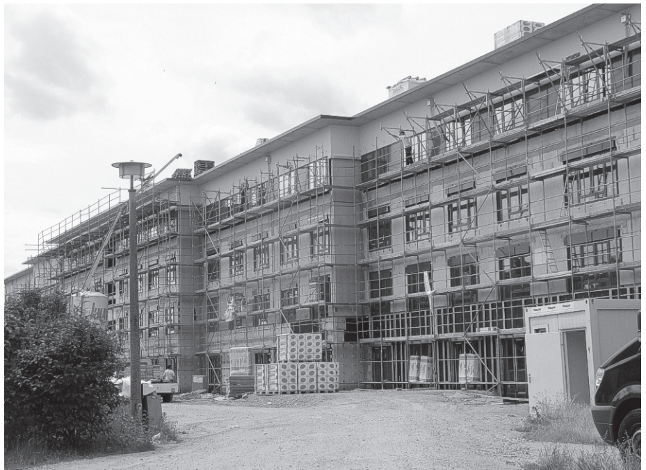
Neues Bettenhaus, Baustellenfoto vom 04. Juni 2012 (Foto: Sandra Kobelt)
