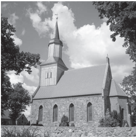
Die Feldsteinkirche in Stendell nach der Dachsanierung
