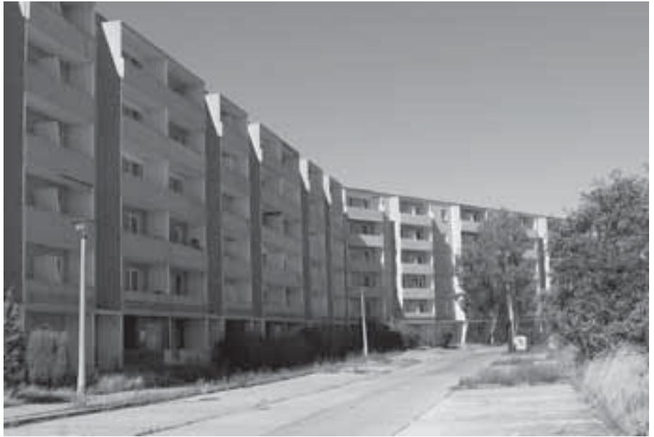
Die Wohnblöcke Grambauerstraße 2–24 wurden bereits im September für den Rückbau vorbereitet.
