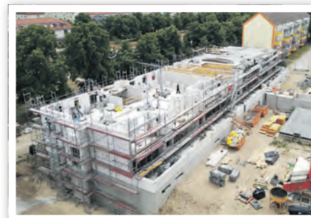
Baumaßnahme „Augustiner Tor“
