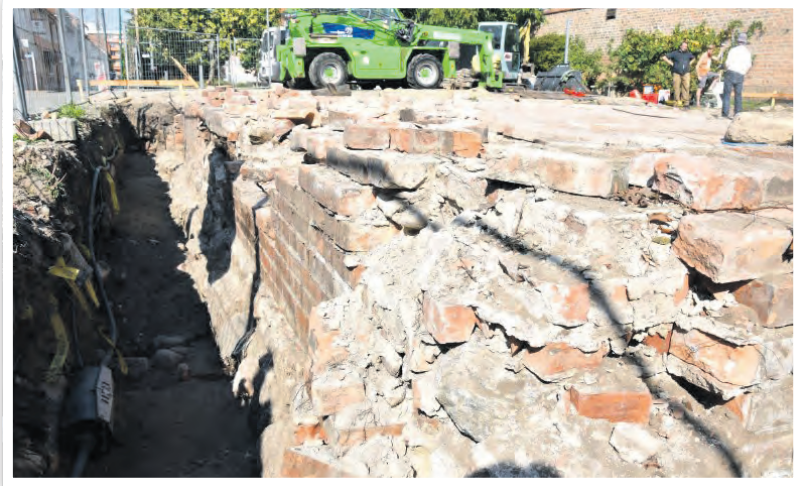
Baustart für die Überdachung des historischen Fundamentes
