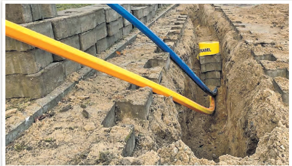
Kabelverlegung im Camp
