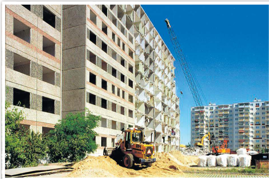
Abriss der Hochhäuser entlang der Leverkusener Straße.
