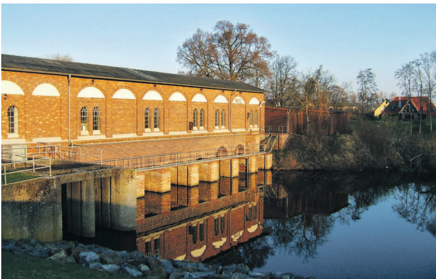
Das wohl bekannteste Schöpfwerk in Schwedt/Oder wurde 1892 errichtet. Einen Artikel zu den Schwedter Schöpfwerken finden Sie im Innenteil.
