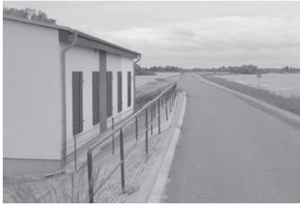
Das Schöpfwerk 2 befindet sich gegenüber des Wohngebietes „Schlosswiesen“.
